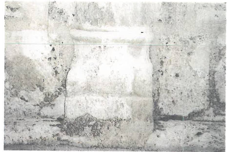
Abb. 46: Scheiblingkirchen, Pfarrkirche, Säulenbasis der Fassadengliederung. – Photo 1997; Gerd PICHLER.
