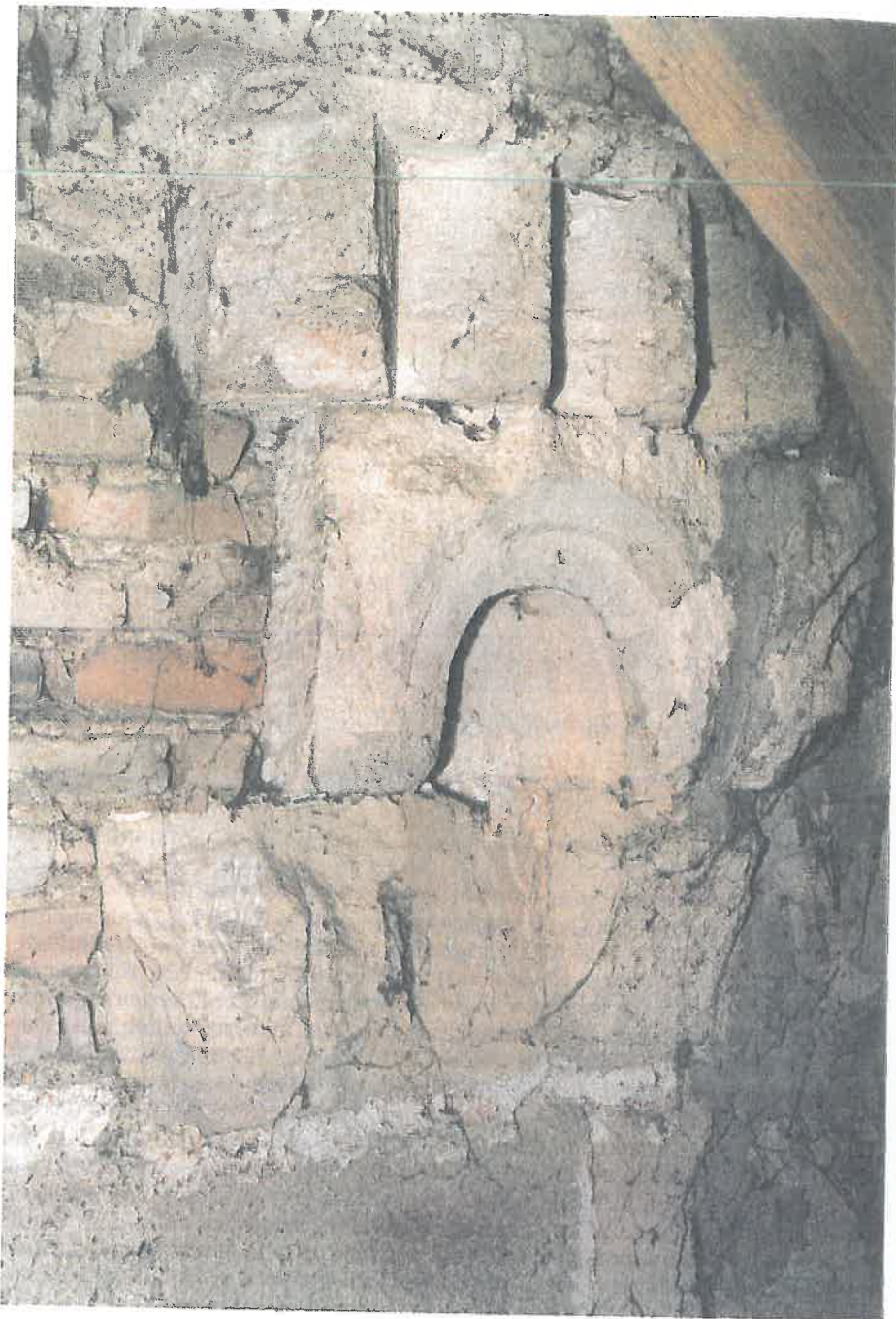
Abb. 24: Petronell, Johanneskirche, Rundbogensegment mit Zahnschnittfries im Dachboden der Apsis (ehemals an der Außenseite). – Photo 1997; Gerd PICHLER.
