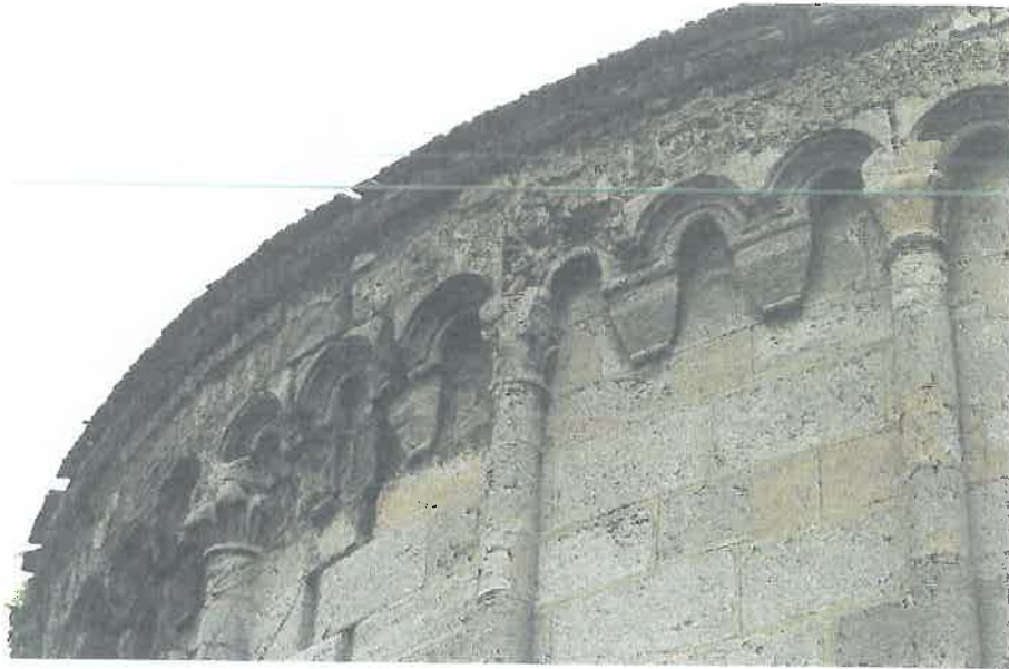
Abb. 15: Petronell, Johanneskirche, Rundbogenfries mit vermauerten Zahnschnittfries an der Südwand. – Photo 1997; Gerd Pichler.
