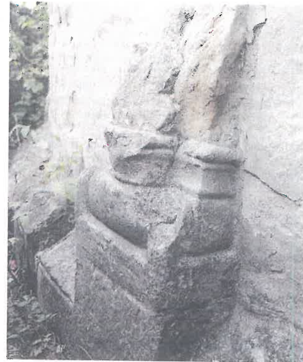
Abb. 50: Markersdorf, St. Lorenzen, Säulenbasis der Südfassade. – Photo 1997; Gerd PICHLER.
